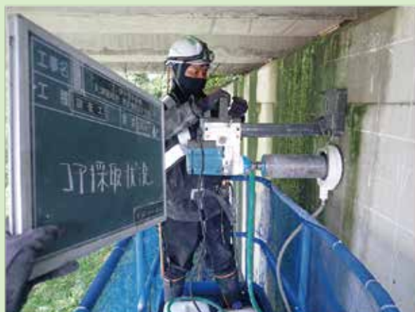
橋梁調査状況
